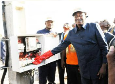
Mise sous tension de l'extension de l'Electrification à Niéméné
